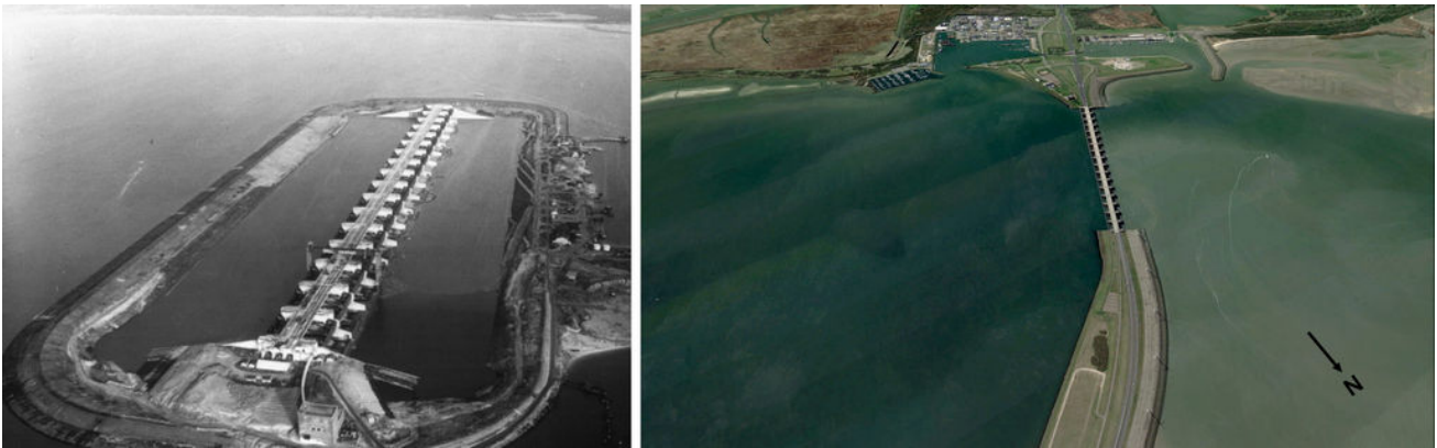
Figure 3.5: left: Construction pit (period 1958-1968) (Beeldbank RWS); right: overview Haringvlietdam (Google Earth, 2022)
