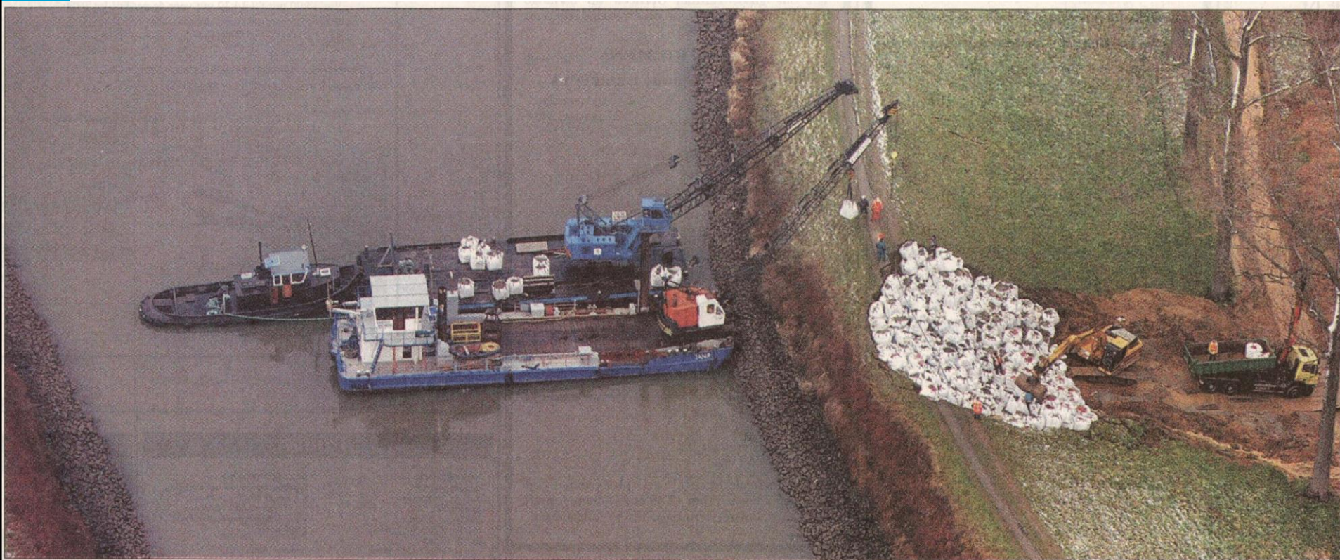
Grote zakken zand, zogeheten bigbags, versterken de dijk van het Julianakanaal in Stein.
